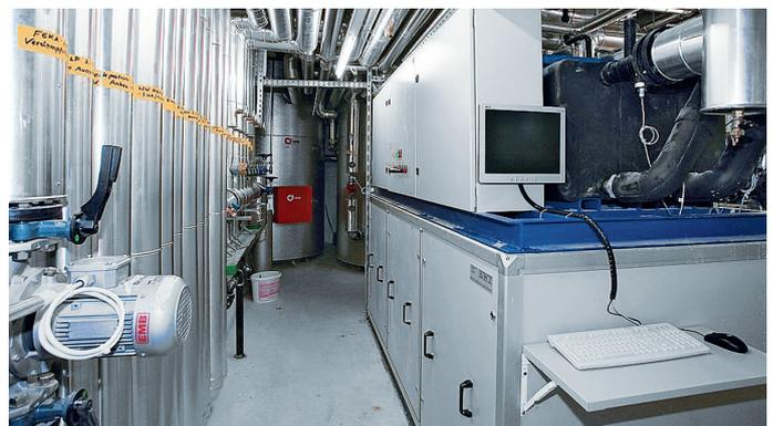
Diese Abwasser-Wärmepumpe mit einer Leistung von 150 kW wird zur Trinkwassererwärmung genutzt.
