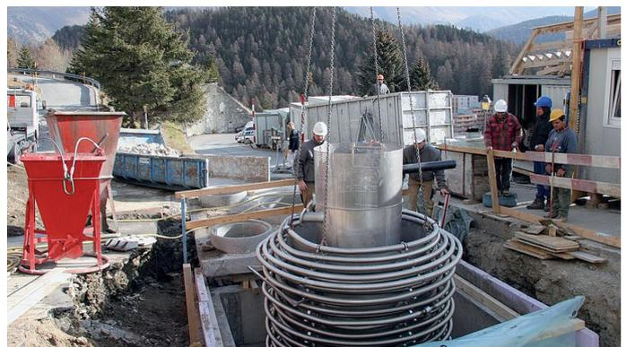
Dieser Abwasserschacht dient als Primärquelle zur Warmwasseraufbereitung.
