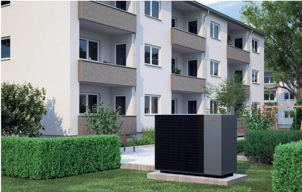
Luft/Wasser-Wärmepumpe Vitocal 250-A PRO für ein Mehrfamilienhaus
